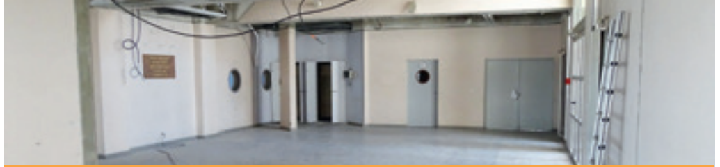
Travaux de la MJC
