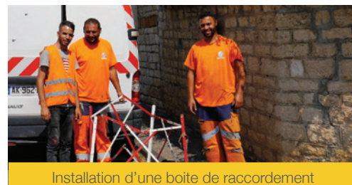
Installation d'une boîte de raccordement
