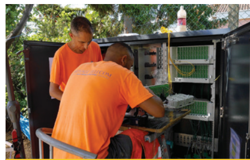
Installation d'une armoire route de Neuville
