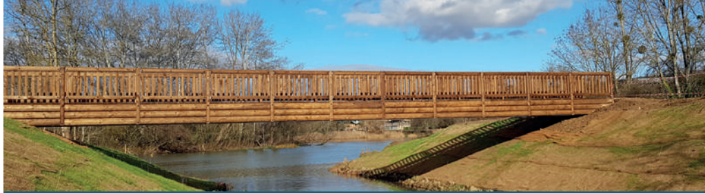
Après travaux du plan d'eau de Chamalan
