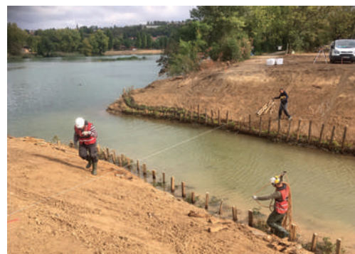
Travaux du plan d'eau de Chamalan
